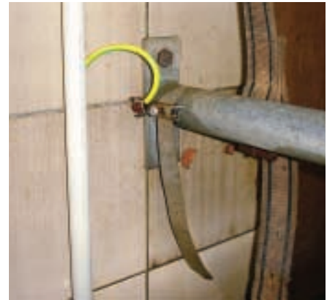
Bild 7: Potenzialausgleich im Melkstand.
